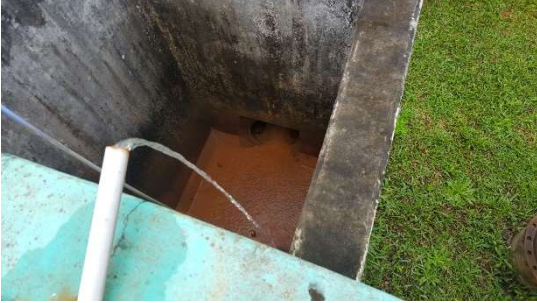
Figura 39: Reservatório elevado de 500 m 3
