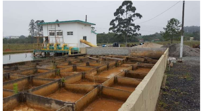
Figura 17: Lagoa de decantação e Estação de recalque de Água Decantada (ERAD)
