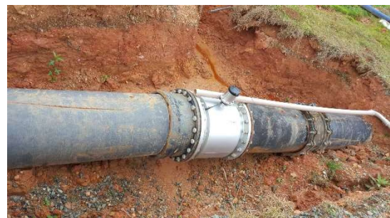
Figura 42: Macromedidor instalado na nova adutora de água tratada
