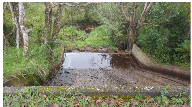
Figura 11: Represamento da lagoa de acumulação
