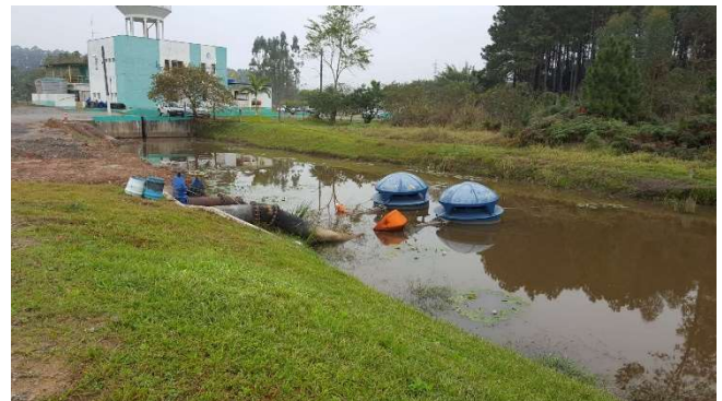
Figura 9: Bombas flutuantes de captação de água
