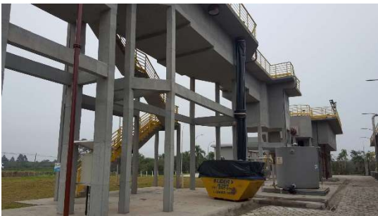
Figura 49: Remoção de areia e gordura
